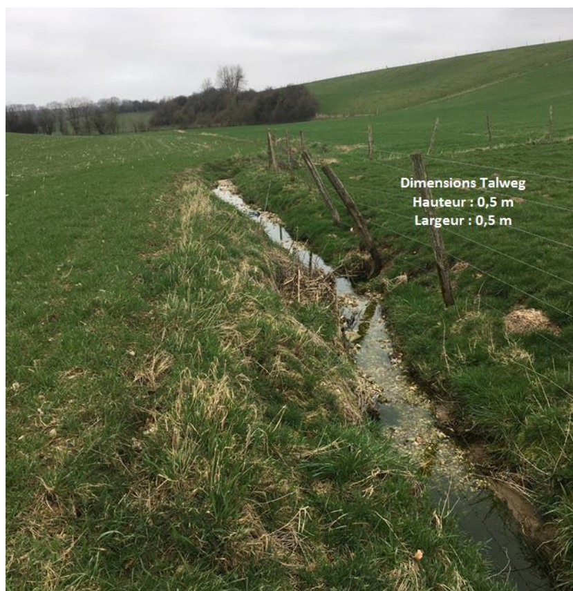
Photographie 3 : Vue au niveau du nœud 4
